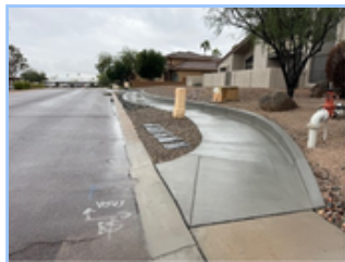
Hamilton Sidewalk Infill.jpg
